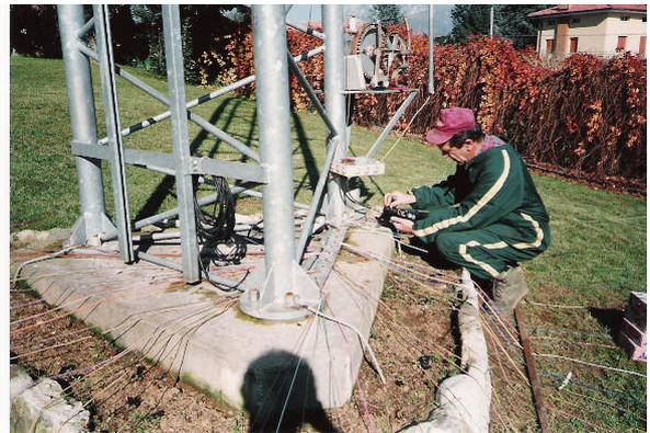
Con l'aggiunta di un centinaio di radiali, in autunno, era diventata una antenna trasmettente della massima efficienza che mi permise di conquistare, anche da casa mia ad Aveacco, il
