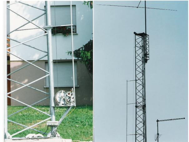
Il traliccio era di costruzione professionale, predisposto con carrello elevatore, cuscinetti, rotore, ecc., mai utilizzati; installai solo la 4 elementi yagi dei 15 metri, quale cappello capacitativo per farlo risuonare in 160 metri ed un tubo di alluminio di 20 metri in parallelo quale gamma match.
